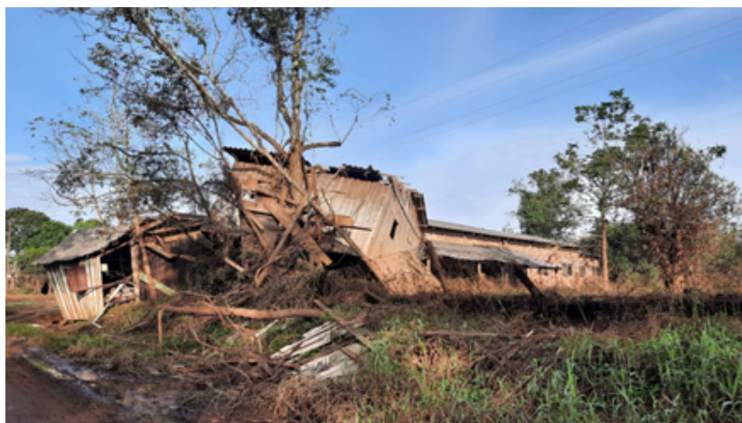
Figura 2 – Casas levadas pela enxurrada - Lajeado-RS
